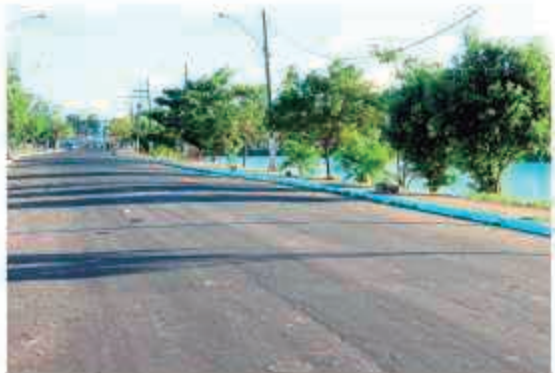
A avenida Beira-Rio é o principal ponto de encontro da cidade
